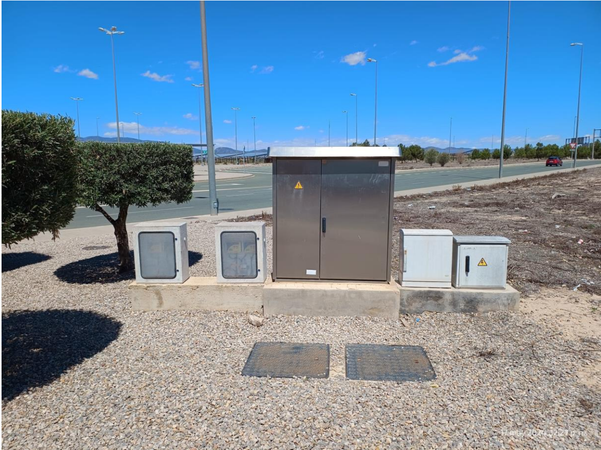
Foto 2.2.A.2. Zona instalación del nuevo cuadro de control.
