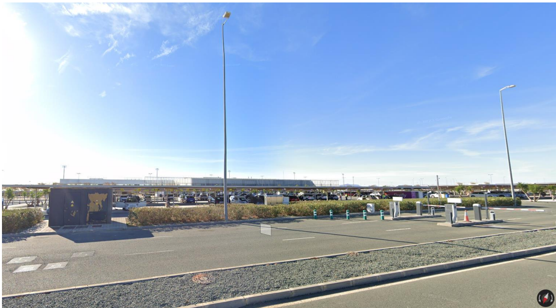
Foto 2.2.D.1. Plano general zona instalación del nuevo cuadro de control.
