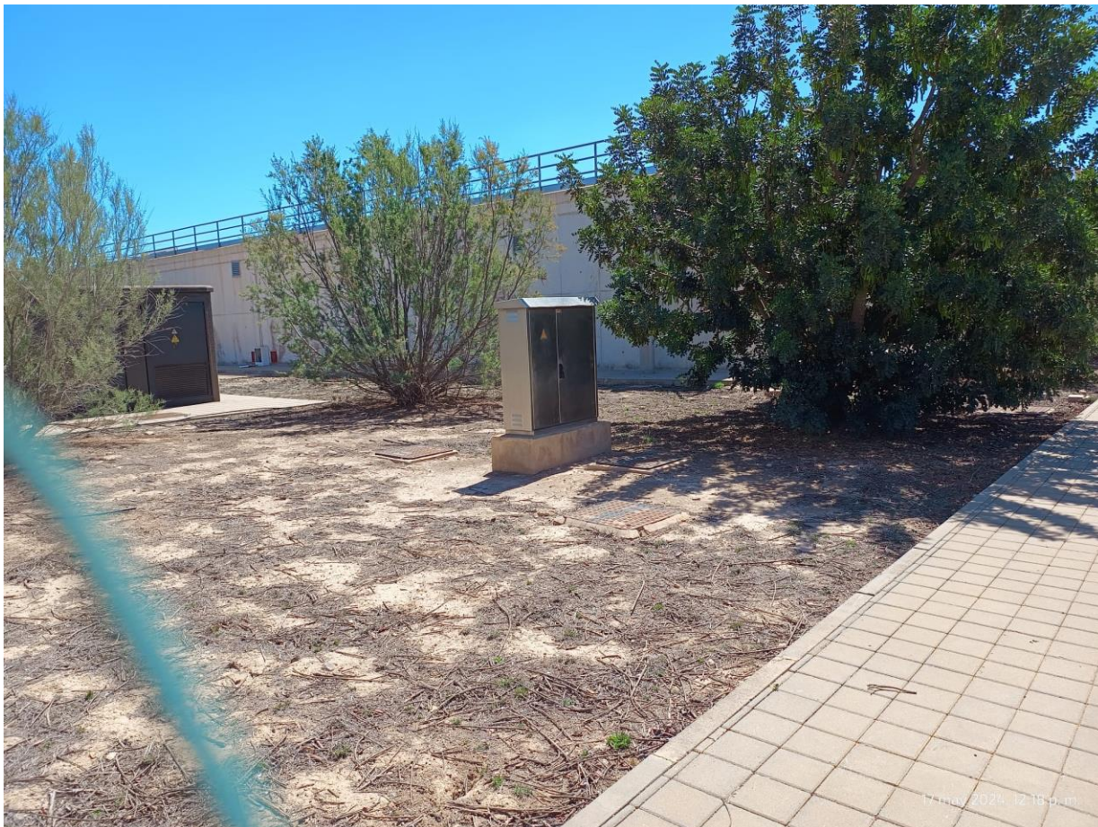
Foto 2.2.B.1. Plano general zona instalación del nuevo cuadro de control.
