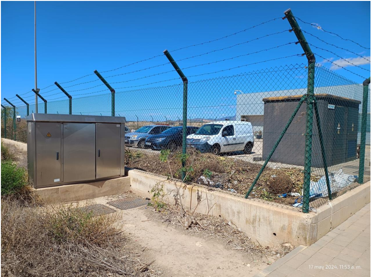
Foto 2.2.C.1. Plano general zona de trabajo.
