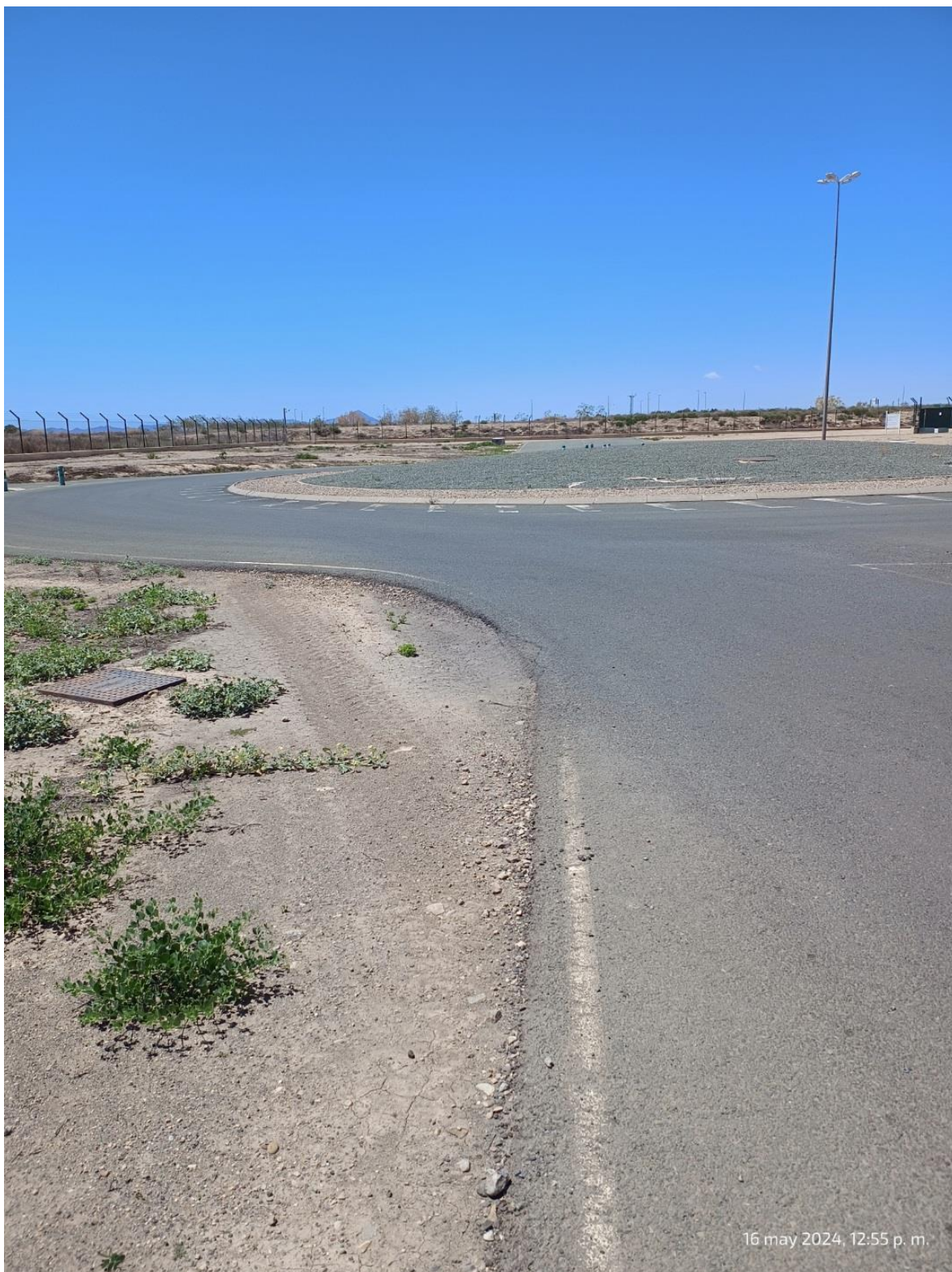
Foto 2.1.A.2. Misma foto que la anterior pero tomada de Norte a Sur.
