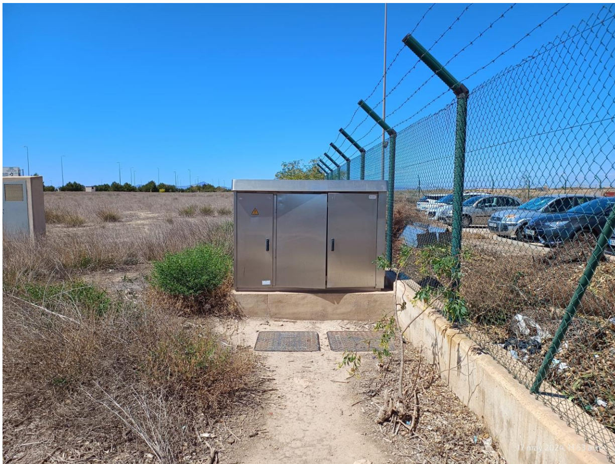
Foto 2.2.C.2. Detalle zona instalación del nuevo cuadro de control.
