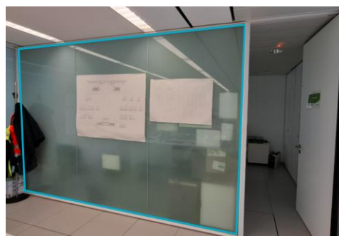
Vidriera a sustituir de sala informática
