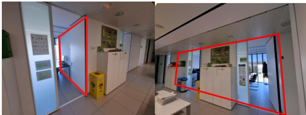
Vista de la zona a reformar indicando las dos divisiones a retirar.
