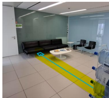
Actuación en entrada para caja empotrada en suelo.
