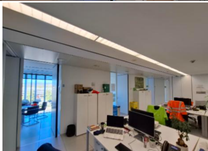
Fotografías de estado actual de las zonas a reformar de P10.
