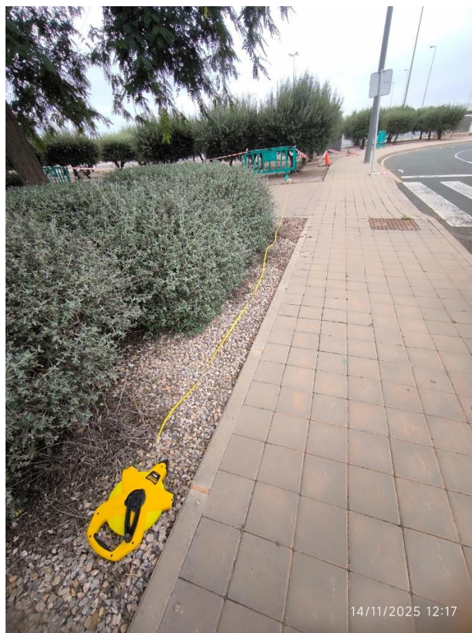
Foto I.2.D. Detalle medición distancia tramo cuadro de Metays hasta arqueta que intercepta el anillo 3 de fibra.
