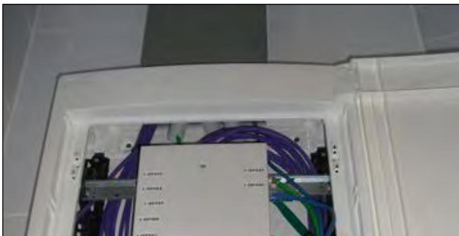
**Figura 2** Canalización del punto de consolidación a canalización troncal de comunicaciones.
