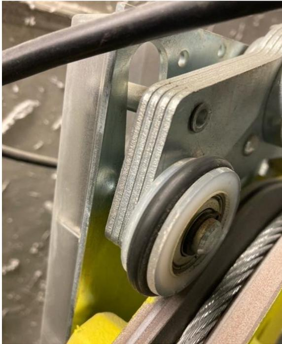
Sustitución de la junta elástica del limitador, por encontrarse en mal estado, se trata de un elemento de seguridad
