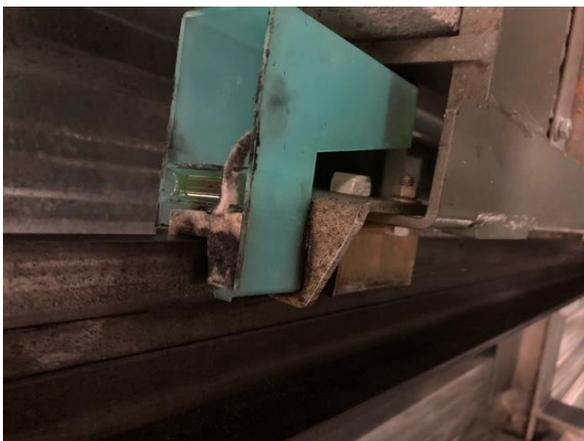
Sustitución de las 4 guarniciones de cabina, por desgaste y cuarteada debido al tiempo que se encuentra el equipo fuera de servicio.
