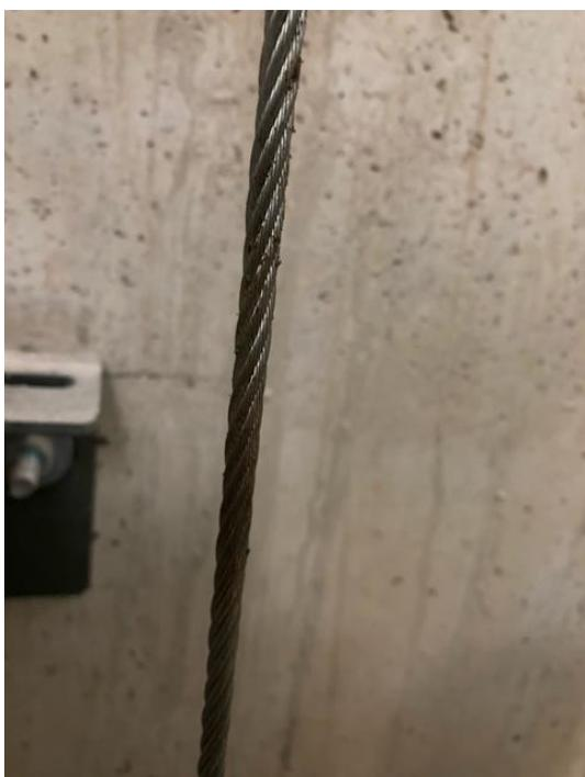
Sustitución del cable de limitador por encontrarse en mal estado y con presencia de oxido en algunos tramos. Se trata de un elemento de seguridad.
