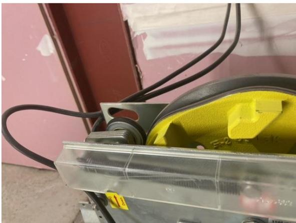
Sustitución de la junta elástica del limitador, por encontrarse en mal estado, se trata de un elemento de seguridad.
